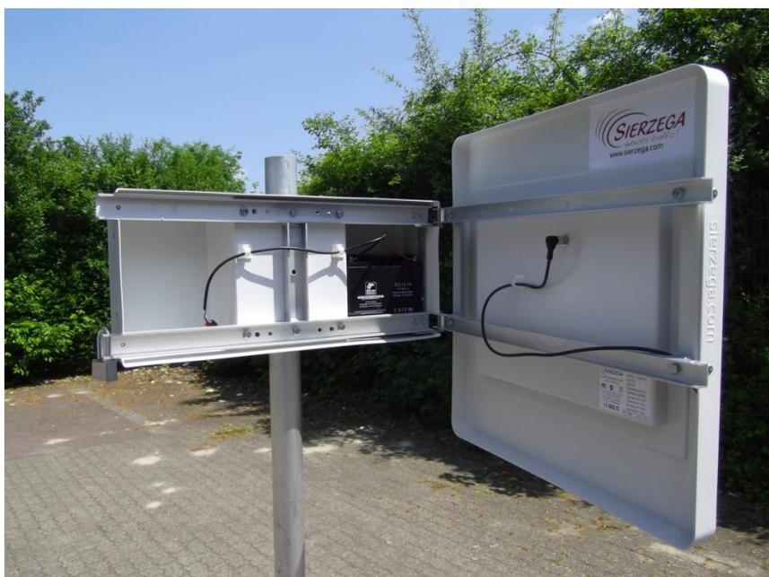
Sollte die **Montage mit einem Stahlband** erfolgen, dann muss das Stahlband hinter dem U-Profil mit schwarzem Kantenschutz auf der Rückseite der VG2L durchgeführt werden. Danach führt man das Stahlband eng um den Masten und schließt es mit dem mitgelieferten Befestigungszubehör.
